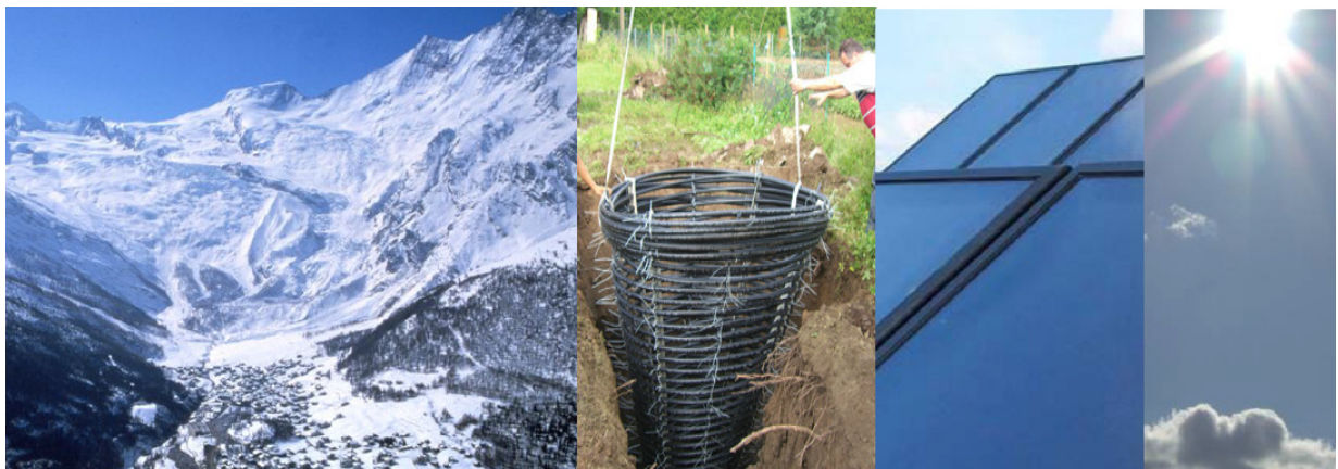
Die überschüssige Sonnenenergie aus dem Sommer wird im Boden für den Winter gespeichert. (Quelle: Bericht Elimes AG)
