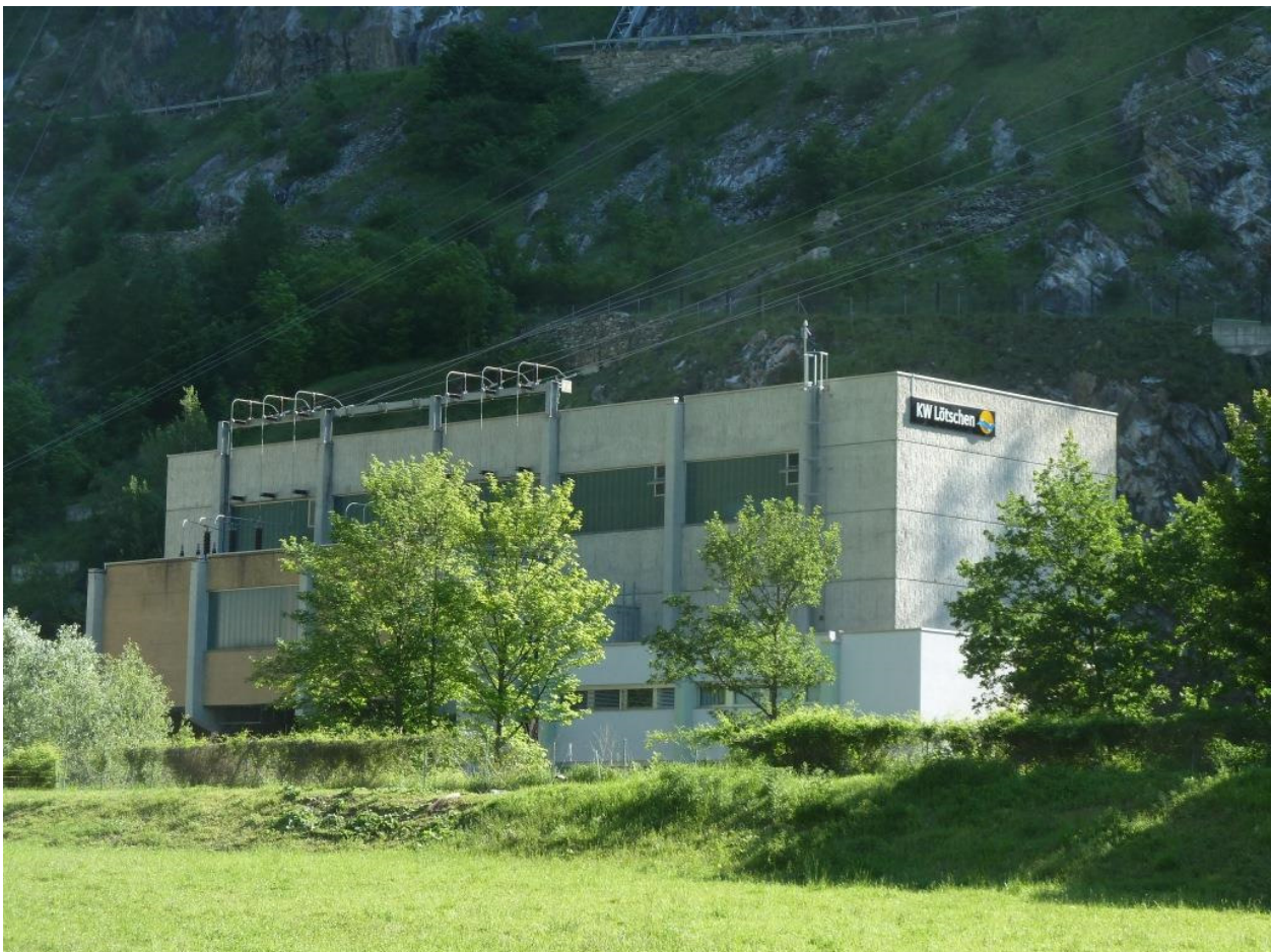
Kraftwerkzentrale Löttschen, Steg
